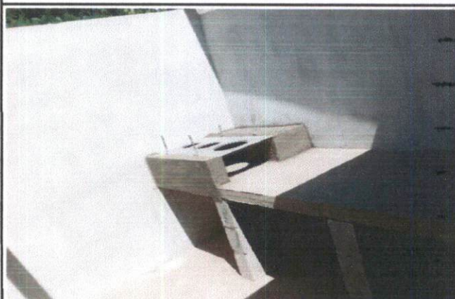
Foto 4: REPARACIÓN O SUSTITUCIÓN DE ÁREA DE COCINA.
