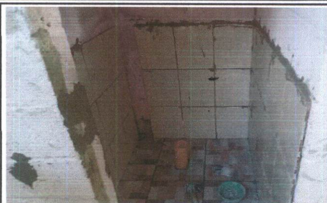
Foto 2: MEJORAMIENTO DE SERVICIOS SANITARIOS Y SUS ACCESORIOS.
